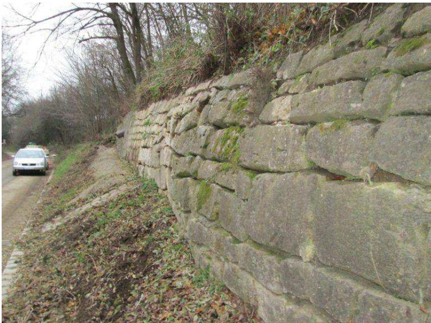
Bild 2: Seitenansicht von Ost nach West, starke Verwölbung, im hinteren Drittel der Mauer, stark gestörtes Gefüge
