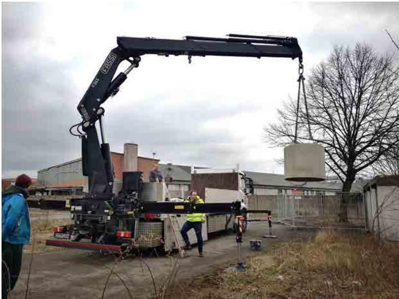
Abb. 19) Aufstellung der mobilen Betonfundamente für Fledermaustürme am Projektstandort
