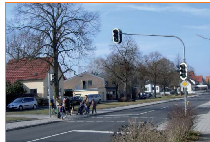
Fußgängerampel in der St.-Michael-Straße
