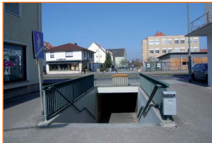
Fußgängerunterführung in der Goethestraße
