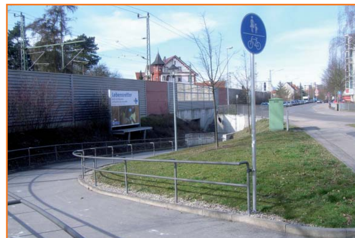
Bahnunterführung in der Frühlingstraße
