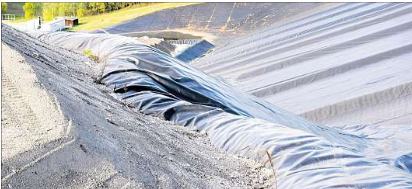
Sauberes Wasser: In der Schlackedeponie Eberstetten wird das saubere Wasser präzise von dem Wasser getrennt, das durch die Schlacke fließt und anschließend gereinigt wird. Fotos: MVA
