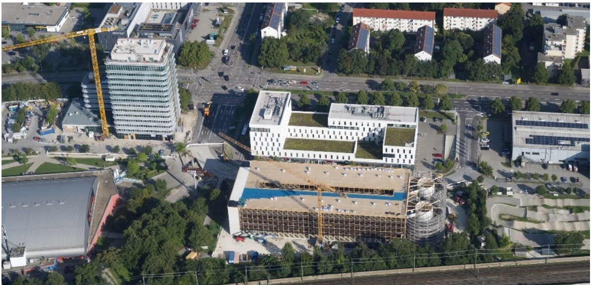
IFG - Parkhaus an der Saturn Arena
