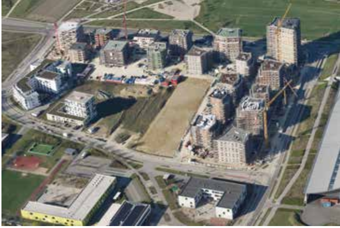
An der Stinnesstraße entsteht ein neues Wohnquartier
