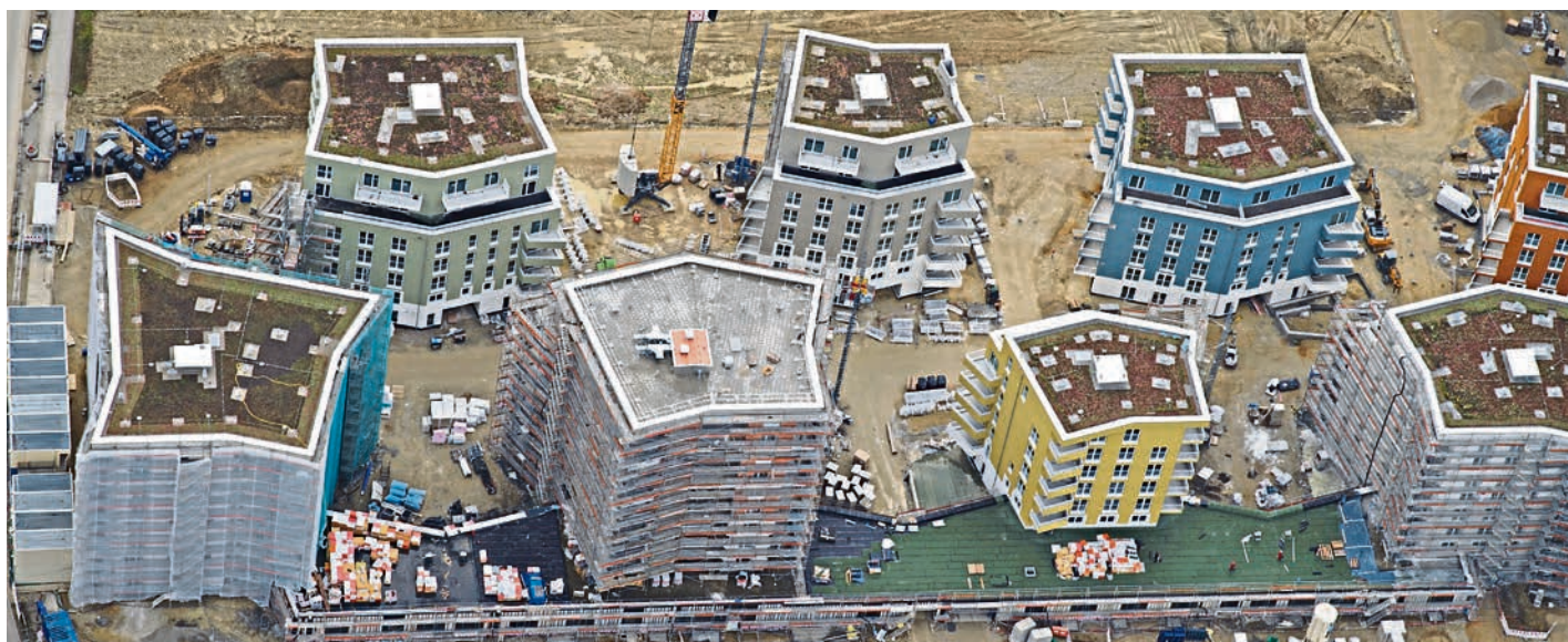
An der Stinnesstraße im Norden entsteht derzeit weiterer Wohnraum.
