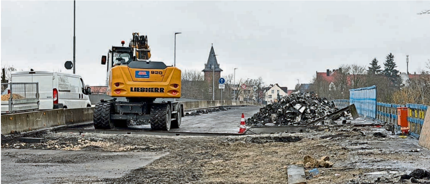
Zu den Aufgaben des Baureferenten gehört auch der Straßenbau, wie hier aktuell die laufende Sanierung der Schillerbrücke.
