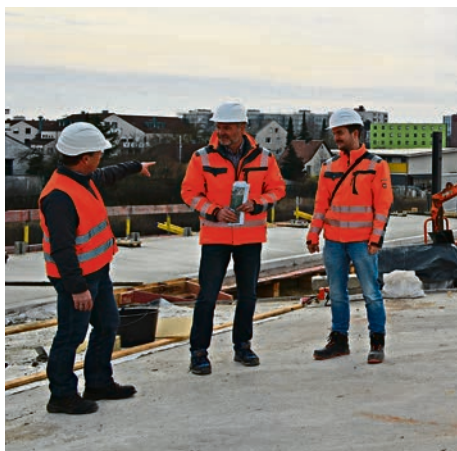
Tiefbauamtsleiter Andreas Dormeier (l.), Bauleiter Tobias Hentschel (r.) und Projektleiter Norman Bischoff auf der neuen Brücke mit Blick auf die Marktkaufkreuzung. Foto: Gooss
