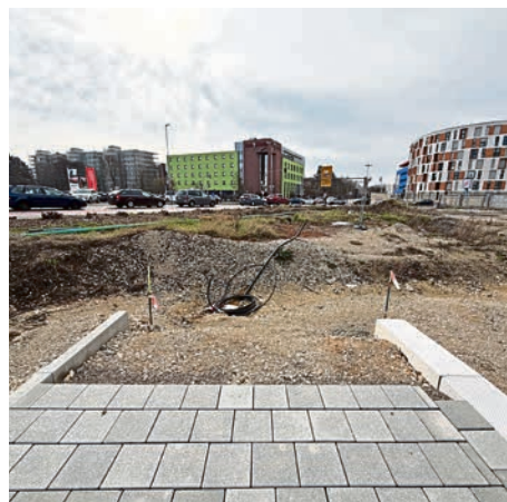
Nach der Fertigstellung der Brücke beginnt der umfangreiche Umbau der Marktkaufkreuzung in drei Bauphasen. Foto: Michel
