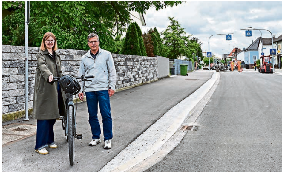
Tiefbauamtsleiter Andreas Dormeier und Fahrradbeauftragte Theresa Schneider freuen sich über die Verbesserungen nach den Umbaumaßnahmen im Unterhaunstädter Weg. Foto: Wobker
