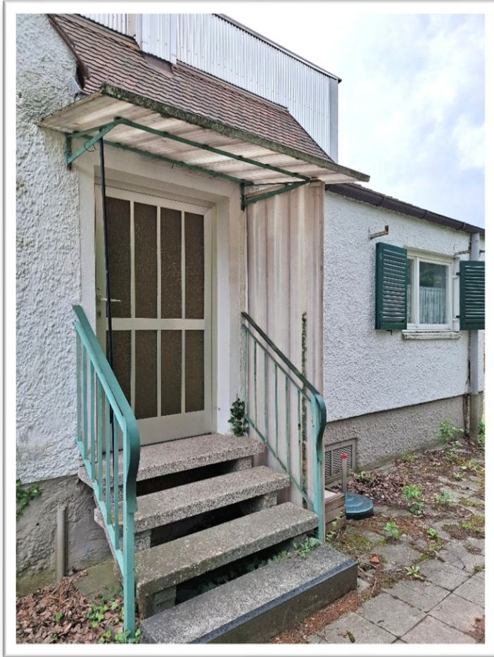
Haustür mit Zugangstreppe und Vordach
