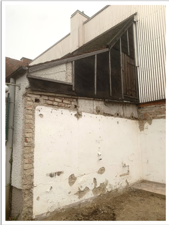
Westliche Fassade nach Abbruch Anbauten
