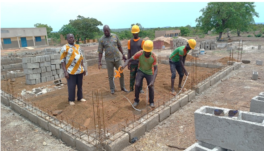
Bauarbeiten am Speisesaal, April 2025
