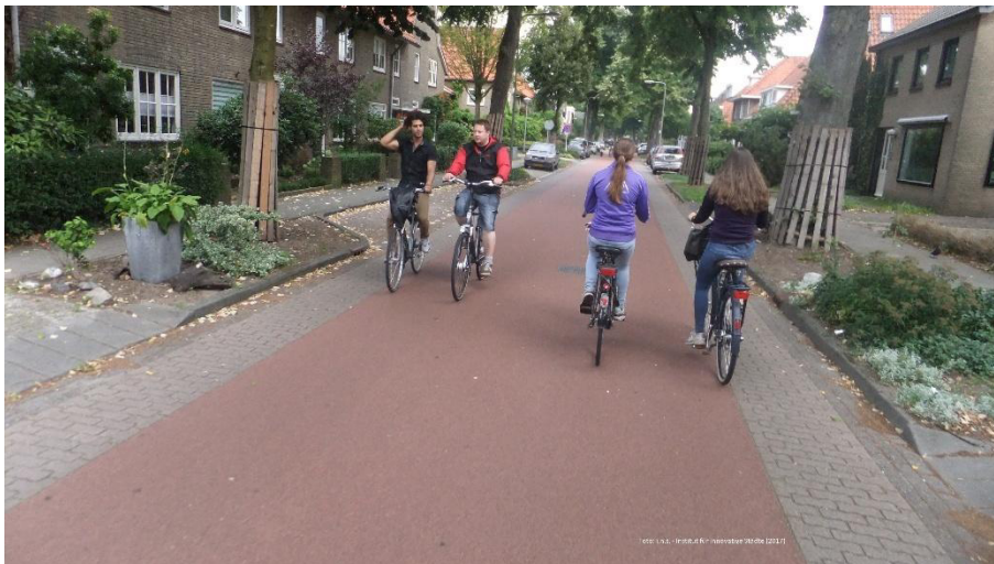
Abbildung 21: Sicherheitstrennstreifen durch Belagswechsel kenntlich gemacht – hier am Beispiel einer Fahrradstraße, aber übertragbar auf Situationen im Mischverkehr
