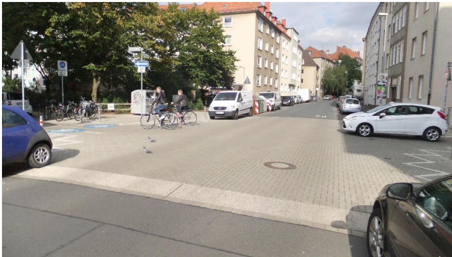
Abbildung 9: Geschwindigkeitsreduktion durch Aufpflasterung, die für den Radverkehr komfortabel zu befahren ist
