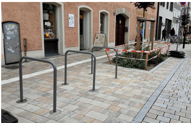
Abbildung 30: Anlehnbügel ohne Querholm, Ausführung Rundrohr (links), Abstände von Anlehnbügeln bei Doppelaufstellung (rechts)
