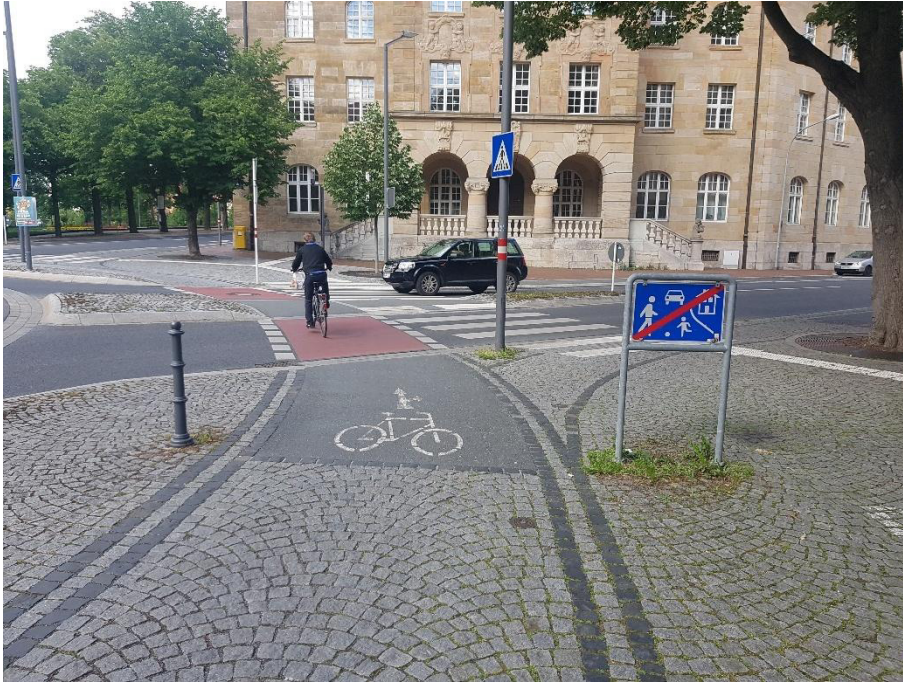
Abbildung 3: Beispiel für Markierungen und Pflasterungen zur Ausbildung einer Fahrgasse
