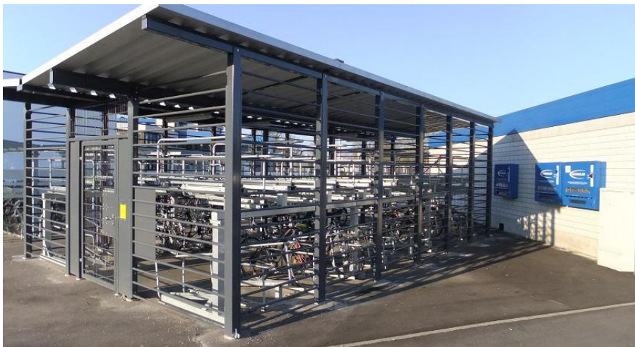
Abbildung 33: Sammelschließanlage mit elektronischer Zugangskontrolle
