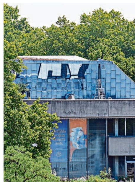
Graffiti-Schmierereien sind ein Problem – zuletzt wurde auch das Stadttheater be- sprayt. Die Fläche konnte inzwischen gerei- nigt werden. Foto: Wobker
