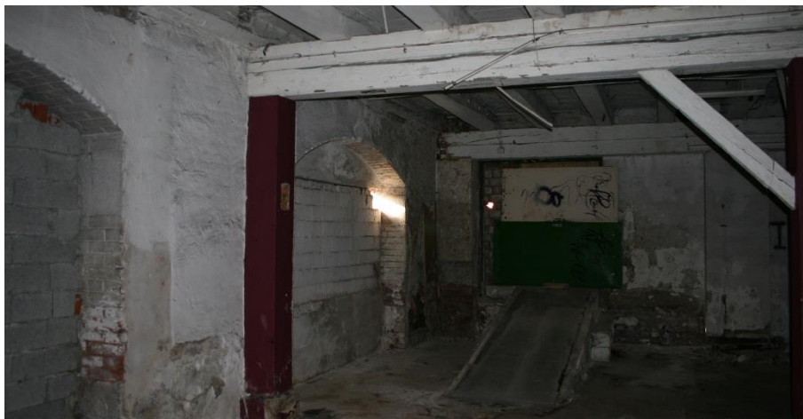
Abbildung 14: Geschützremise Zugangsmöglichkeit Erdgeschoss (Lippl; 17.03.2024)
