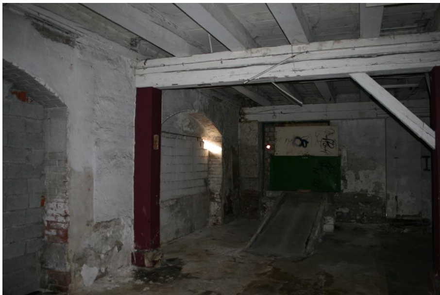
Abbildung 6: Mauerdurchbruch im Erdgeschoss der Geschützremise (Lippl; 17.03.2024)
