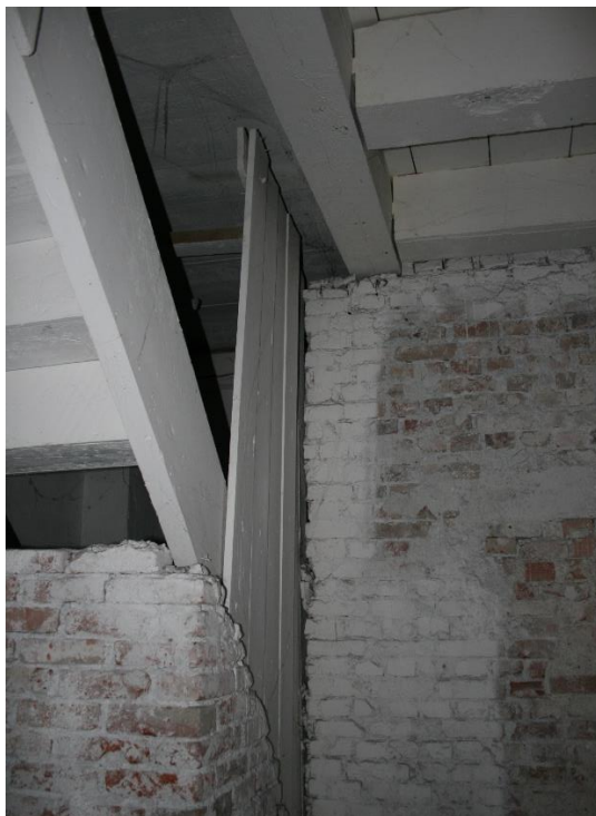
Abbildung 16: Geschützremise Maueranschluss Treppe Erdgeschoss (Lippl; 17.03.2024)
