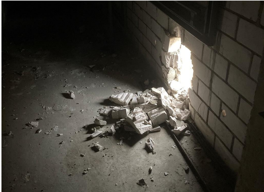
Abbildung 4: Mauerdurchbruch im Erdgeschoss des Körnermagazins (Lippl; 11.02.2024)
