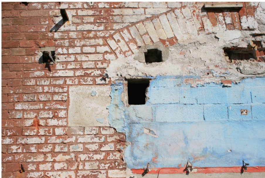
Abbildung 8: Ziegelfassade der Geschützremise (Lippl; 07.05.2023)
