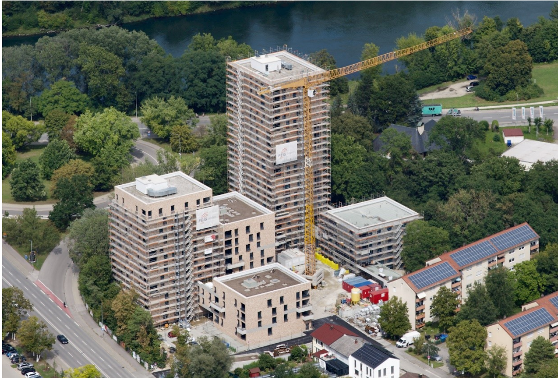
GWG - Baustelle an der Stargarder Straße
