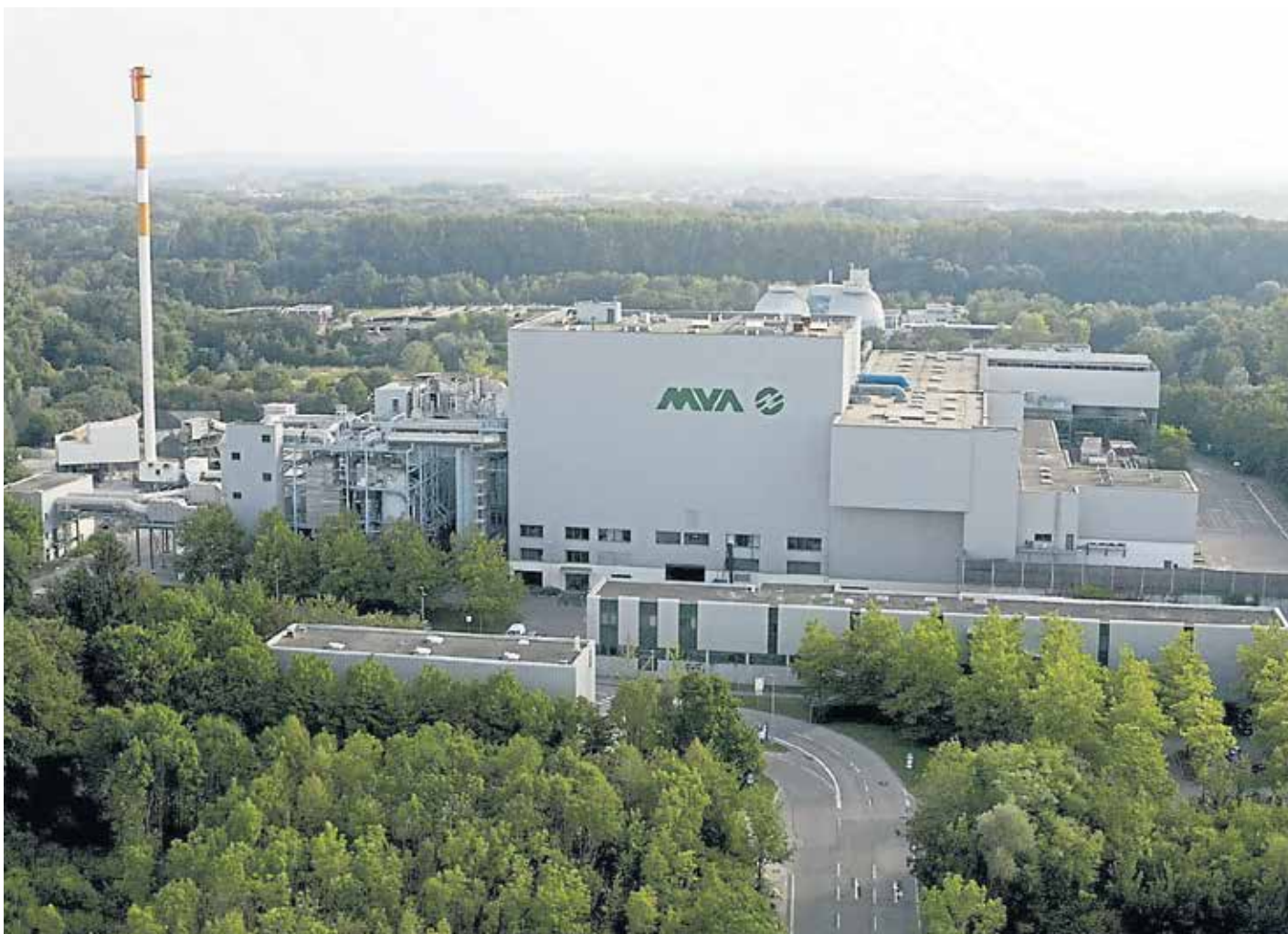
2020 – mittlerweile entsorgt die MVA Ingolstadt mit ihren drei hochmodernen Verbrennungslinien die Region nicht nur, sondern versorgt sie auch mit Strom und Fernwärme.
