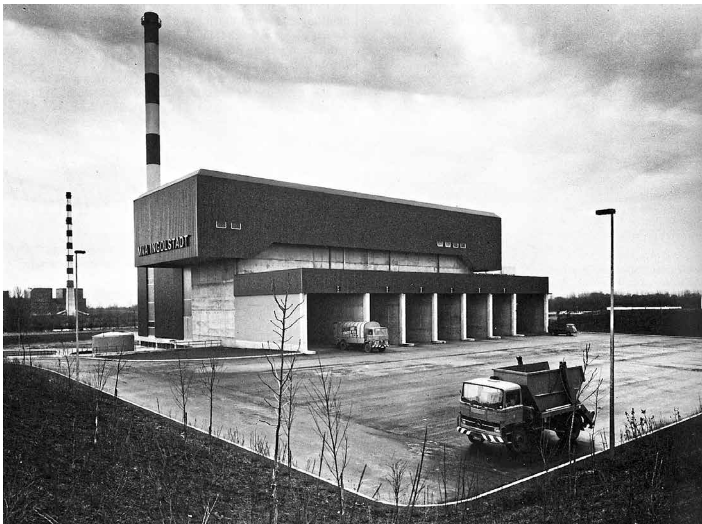
1978 – die zwei Verbrennungslinien der MVA Ingolstadt lösen seit einem Jahr das Müllproblem der Stadt Ingolstadt und Landkreises Eichstätt.
