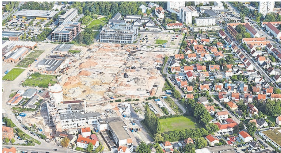
Bezahlbarer Wohnraum steht weiterhin stark im Fokus: Zum Beispiel entstehen auf dem abgebrochenen Rieter-Gelände unter dem Namen „IN-Quartier“ über 3.800 Wohneinheiten.
