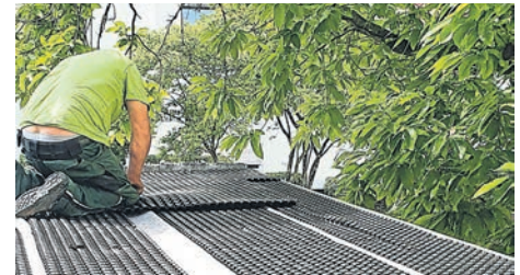
Vorbereitungen zur Begrünung der Glasfaserverteilstation Foto: Ulrich Lindner
