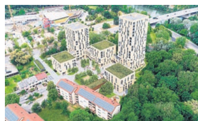
Sozialgerechte Versorgung Aktuelle Neubauprojekte der GWG
