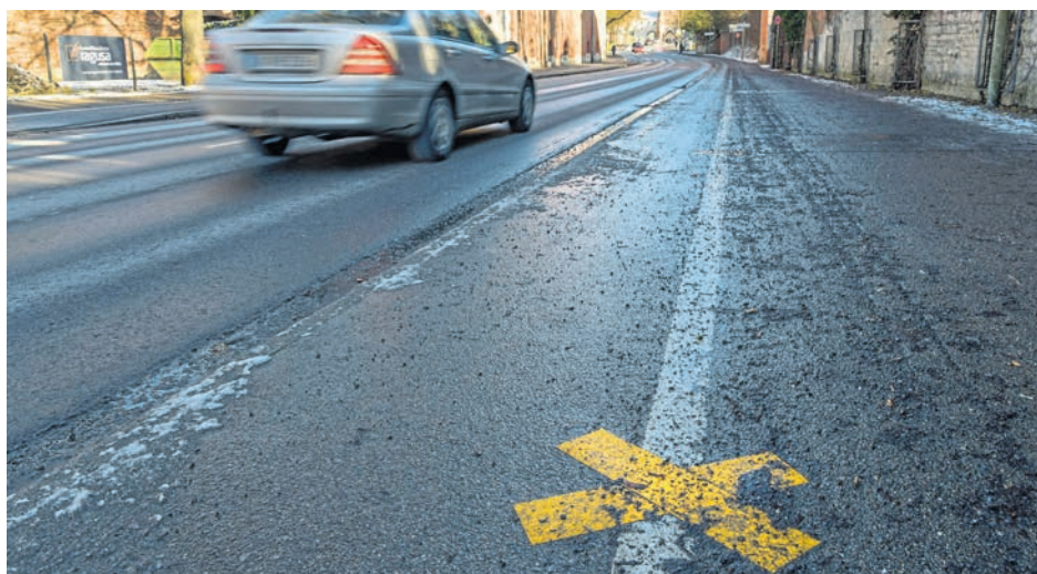
An der Friedhofstraße wurde die Kurzparkzone zugunsten der Radfahrer aufgehoben. Foto: Rössle
