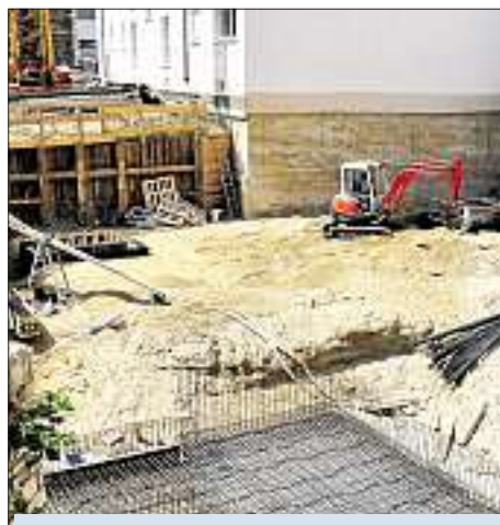
Arbeiten am Erweiterungsbau der Technikerschule in der Adolf-Kolping-Straße. Foto: Michel
