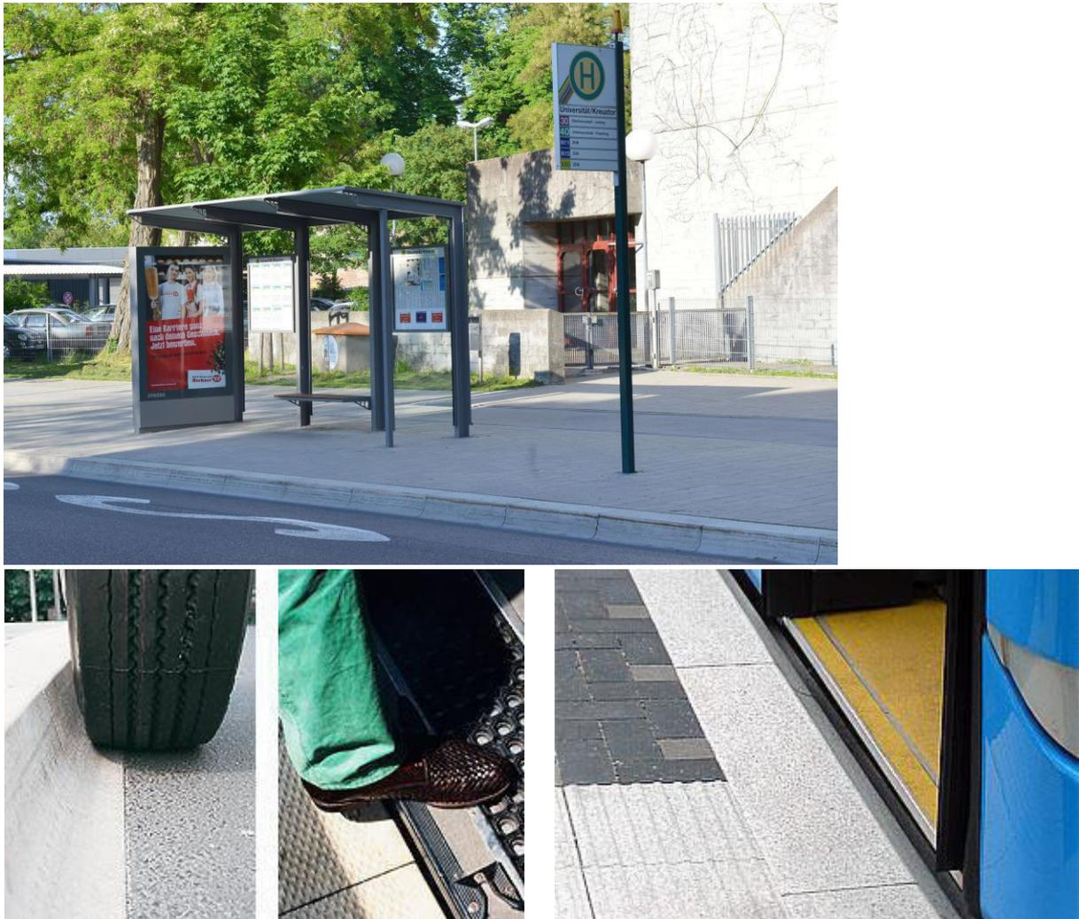
**Abbildung 27** Beispiele für barrierefreie Haltestellen (Quelle: INVG)
