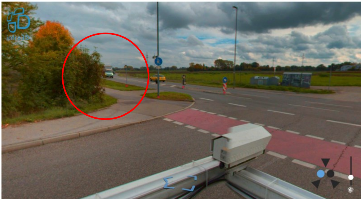
Bild 1: Verdeckte Sicht auf Geh- und Radweg durch Sträucher unmittelbar vor der Radfahrerfurt
